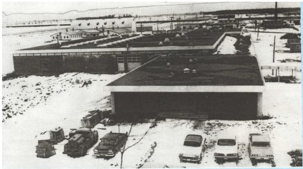
Il y a trente ans... Le mois de juin 1964 voyait l'inauguration d'un nouveau bâtiment de l'École de médecine vétérinaire de la province de Québec, celui de la clinique des grands animaux et des laboratoires de pathologie. Sur la photo, se distinguent, en arrière à gauche, la grange-étable de l'École de laiterie et, au centre, la baraque des premières cliniques des grands et des petits animaux.
